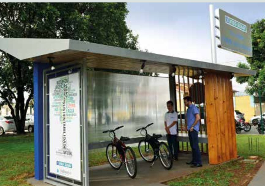
Estação solar de recarga para bicicletas elétricas, projeto de inovação da Faculdade SENAI Ítalo Bologna
