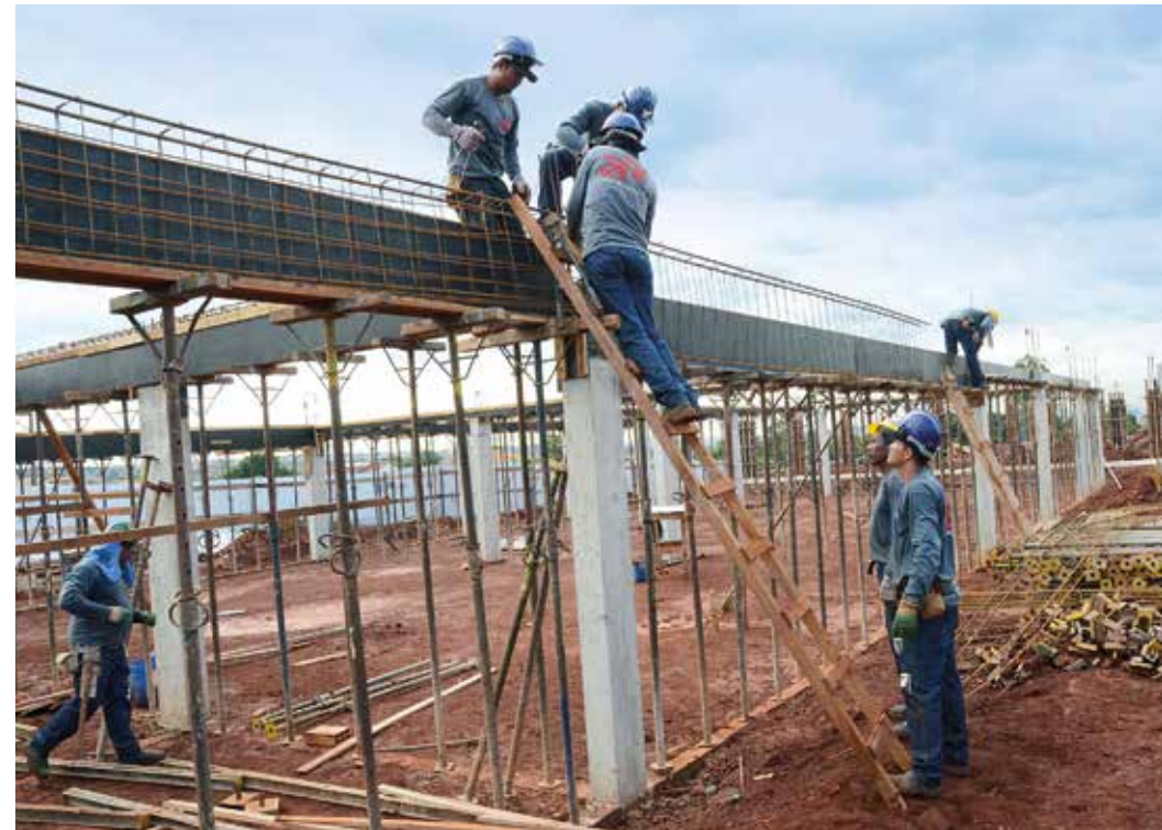
Obras da Unidade Integrada SESI SENAI Jardim Colorado, na Região Noroeste da capital: alta densidade populacional
