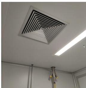
**Figura 5:** Sistema de insuflação de ar purificado nas salas. Fonte: Autores.
