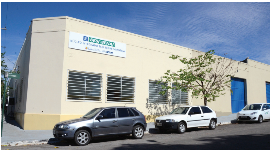
Prédio que abriga o Núcleo Sesi Senai Goianésia, parceria com a usina Jalles Machado e a prefeitura
