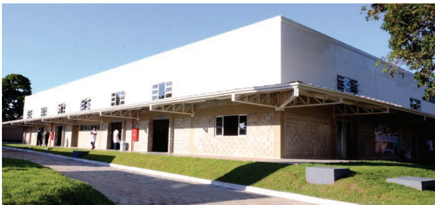
Laboratório integra complexo de ensino exclusivo para construção
